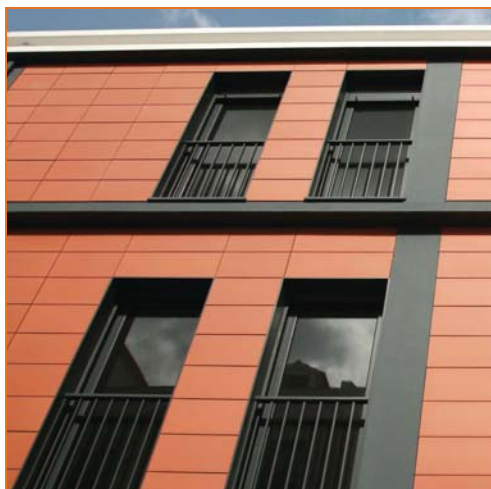
EDIFÍCIO EM NOVA LEIRIA LEIRIA - PORTUGAL
