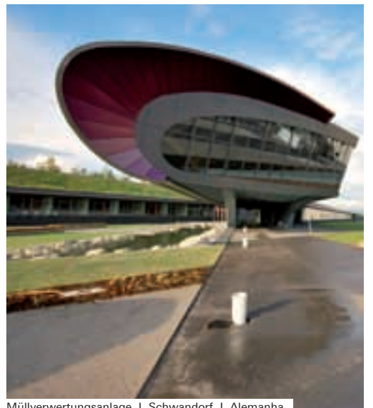
Müllverwertungsanlage | Schwandorf | Alemanha
