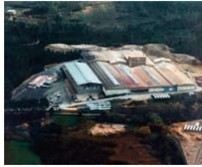
1995-1997 - Reestruturação da empresa com investimento em novos equipamentos de produção, ampliação de instalações e reformulação do lay-out fabril. Grandes melhorias na componente ambiental através da reciclagem de águas e lamas assim como o tratamento dos efluentes gasosos.
